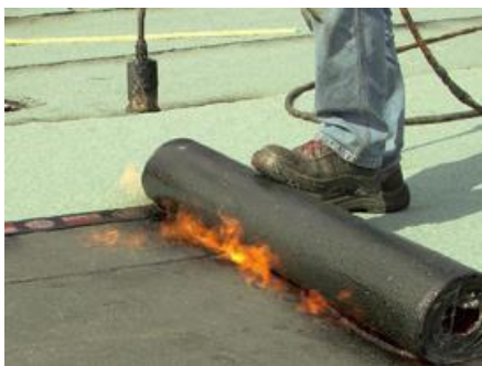
FIGURE 2 Soudage d'une membrane bitumineuse au chalumeau
